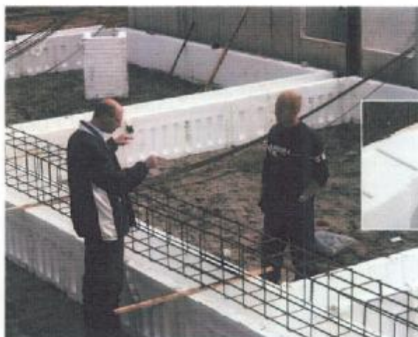
Alex de Vries van C. Van der Hauw Betonbouw krijgt verwerkingstips van Dirk Weijma van De Hoop Betonwaren.
