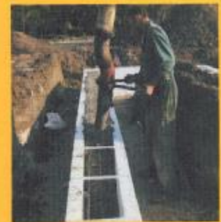
Fundering Nieuwe EPS-fundering belooft tijdwinst
