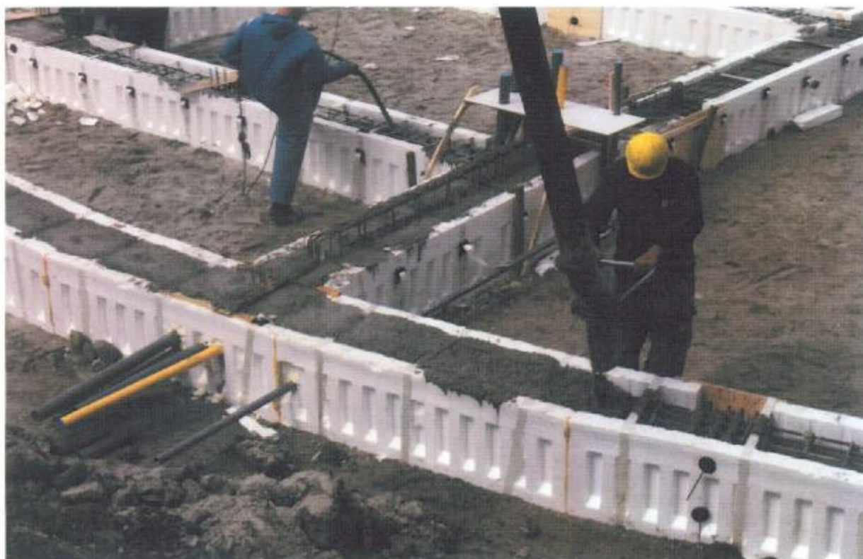
Na het starten van de fundering hoeft de (onder) aannemer niet meer te ontkisten.
